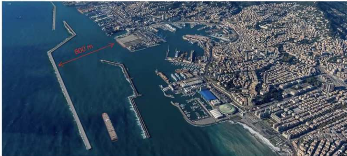
La nuova diga foranea
